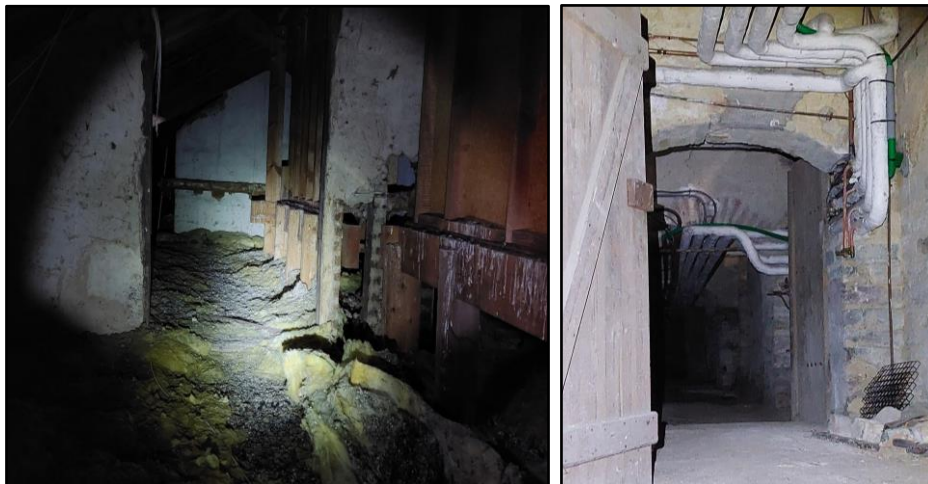
Figure 19 : Vue sur les combles (à gauche) et les caves souterraines (à droite) prospectées à la recherche de chiroptères (photographies prises sur site – ECR Environnement 2024)
