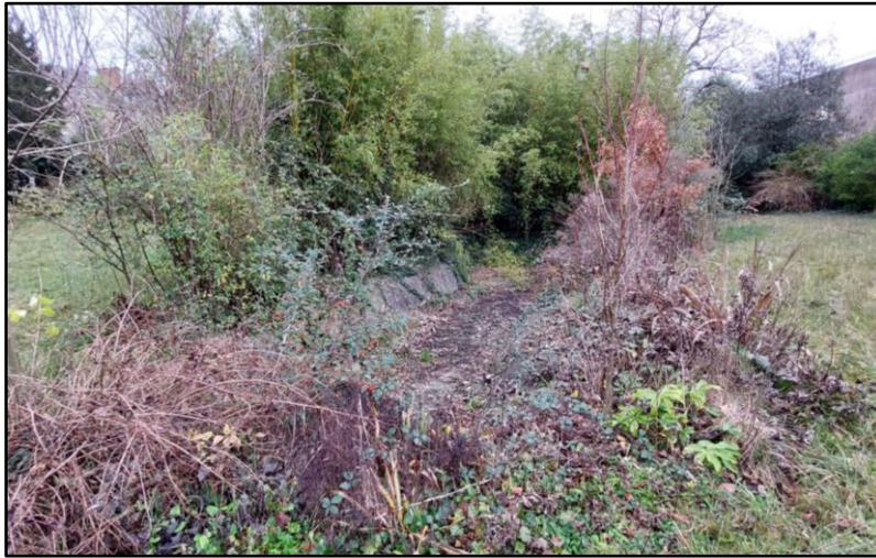
Figure 15 : Vue sur le bassin en assec (photographie prise sur site – ECR Environnement 2024)
