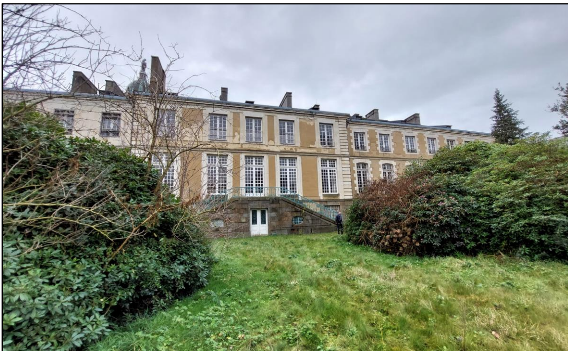
Figure 1 : Vue sur l'aire d'étude (photographie prise sur site – ECR Environnement 2024)
