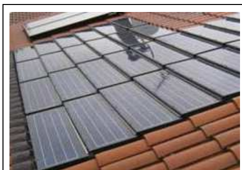
Intégration de Tuiles solaires sur une toiture
