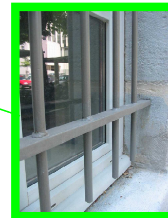
Photo 4 : menuiseries extérieures en bois double vitrage isolant
