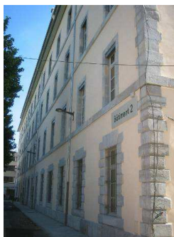
Bâtiment 2 : Façade Nord
