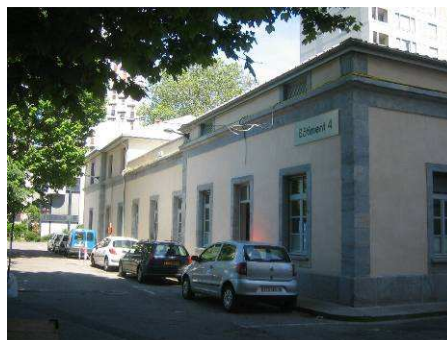
Bâtiment 4 : façade est
