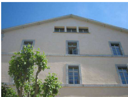
Bâtiment 2 : façade ouest
