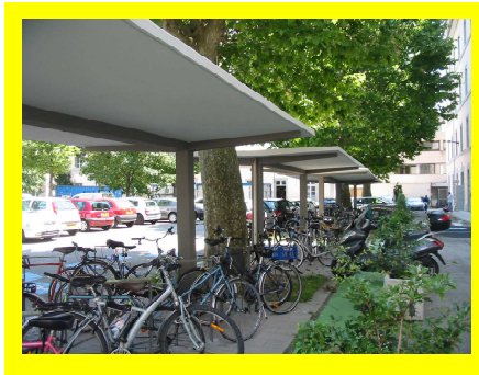
Photo 7 : abris deux roues
