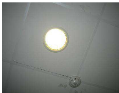
Eclairage de circulation
