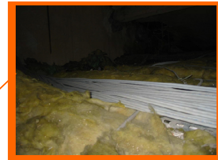
Photo 6 : isolation en laine minérale dans les combles
