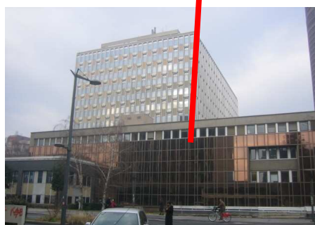
Façade Bâtiment B rue Docteur Bouchut
