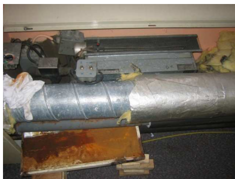
Ejecto-convecteur démonté
