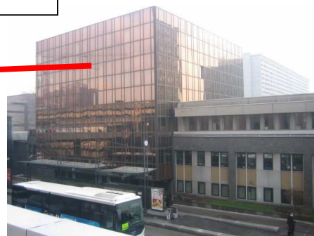
Cube bâtiment A
