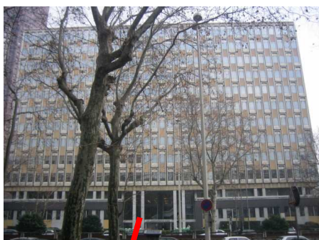
Entrée rue Garibaldi
