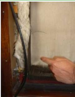
Actuellement, le convecteur est positionné entre la partie du mur en béton et une plaque de bois.
