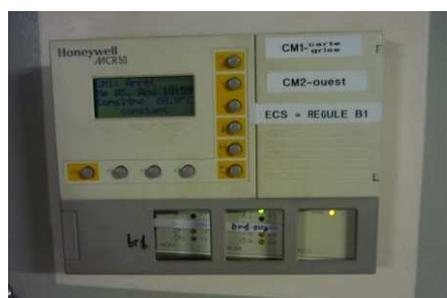
Actuellement, les régulateurs ne sont pas réglés, les températures de consignes sont mal gérées et ne sont pas adaptées à la réglementation.
