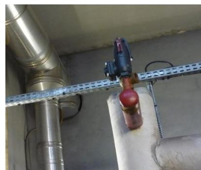
Flow-switch soupape non raccordée
