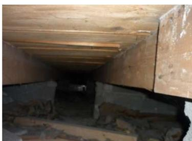
Actuellement, le toit est composé d'une ancienne toiture terrasse recouverte de combles non aménagés. Il est isolé par 8 cm de laine de verre dont l'état est médiocre.
