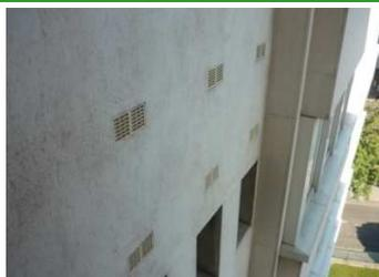
A l'heure actuelle, la ventilation est naturelle dans le bâtiment (bouches d'aération et réglottes de ventilation). L'humidité relative n'est pas régulée et les débits d'air non plus ce qui place le renouvellement d'air en première position avec 43% des pertes.
