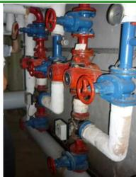
Actuellement, la distribution de chaleur est assurée par 6 circuits régulés par des Vannes 3 Voies.
