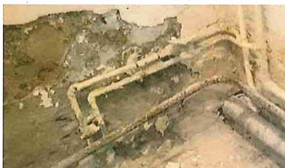
Réseau de chauffage corrodé
