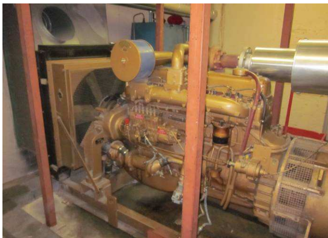
Fig. 5- Groupe électrogène
