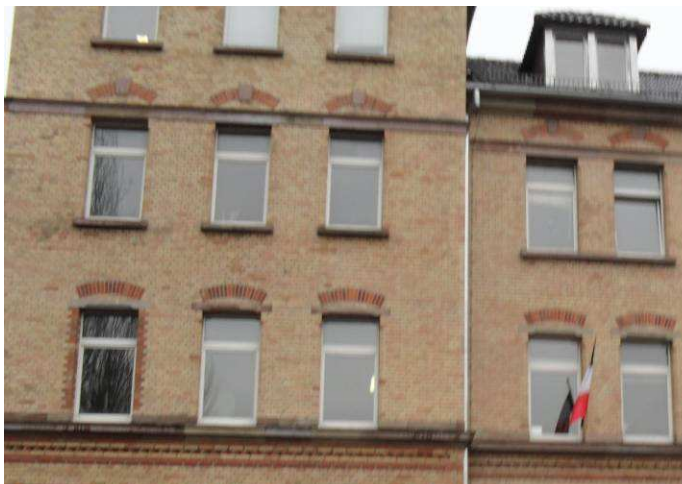
Fig. 1- Vue générale du bâtiment
