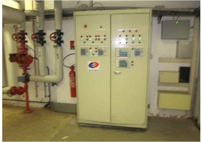
Fig. 2- tableau électrique chaufferie
