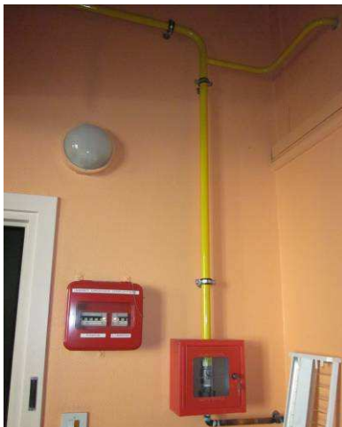
Fig. 7- coupure d'urgence gaz
