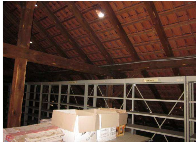
Fig. 8- charpente vue intérieure
