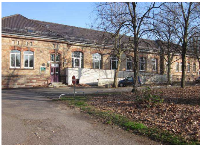
Fig. 1- Vue générale du bâtiment
