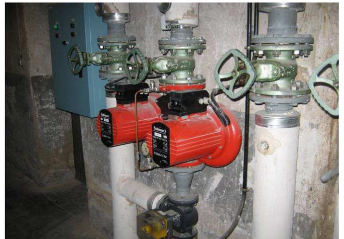
Fig. 10- Pompes de la sous station
