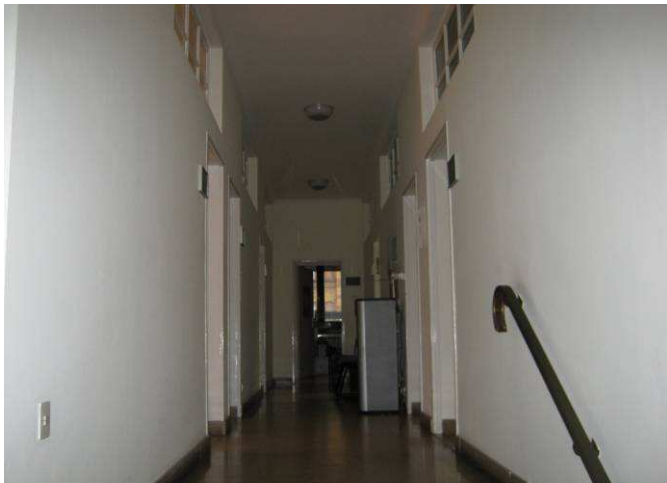
Fig. 7- Couloir et revêtements
