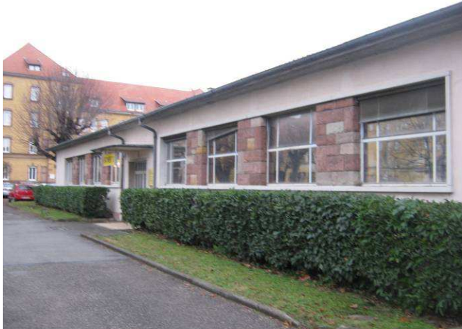
Fig. 1- Vue façade principale du bâtiment
