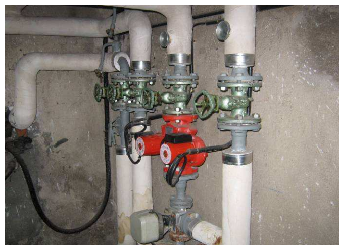
Fig. 10- Installation sous station
