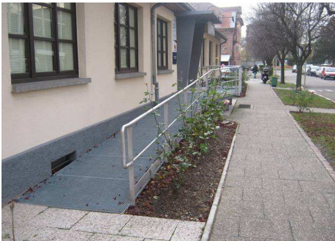
Fig. 3- Rampe accès PMR
