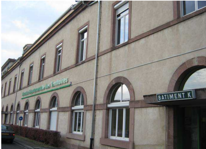
Fig. 1- Vue façade principale du bâtiment
