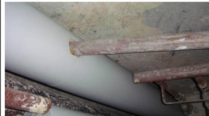
Aile B – R+18 Raccordement collecteur sur colonne verticale aller chauffage
