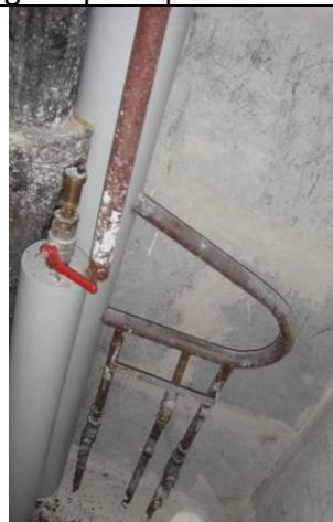
Aile B – R+18 Anciens retour planchers R+19 non raccordés sur colonne verticale retour chauffage
