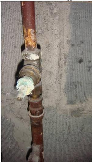
Aile B – R+18 Robinet réglage départ circuit plancher
