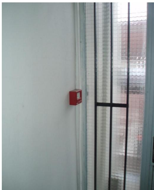
Photo n°P1118917- Déclencheur Manuel
