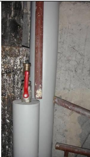
Aile B – R+18 Purgeurs sur colonne verticale retour chauffage
