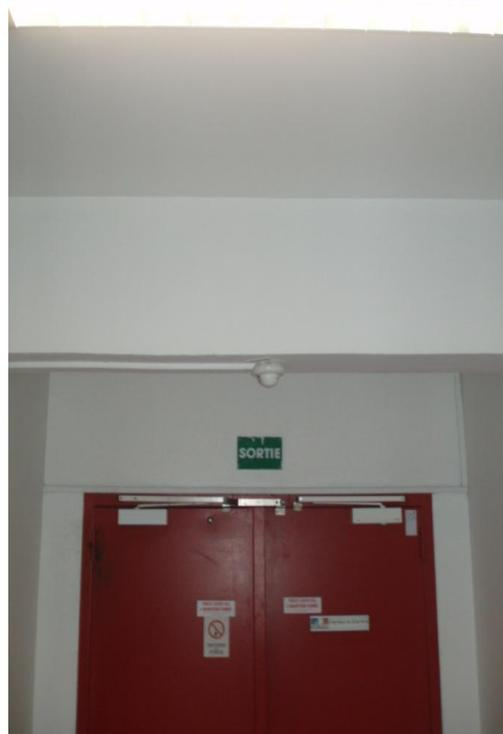
Photo n°P1118914- Détection automatique incendie
